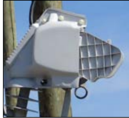
Figure 5-53. Loadbreak cutout cover (Kaddas).
