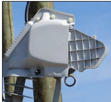
Figure 5-53. Loadbreak cutout cover (Kaddas).
